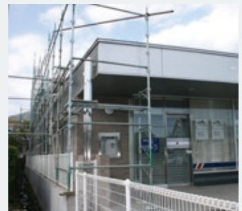
竜巻被害(筑波支店)
