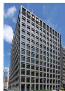
(日本興亜日本橋ビル全景)
