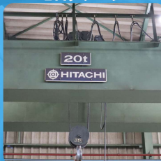
20tクレーン
