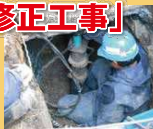
支持杭(鋼管)挿入状況
