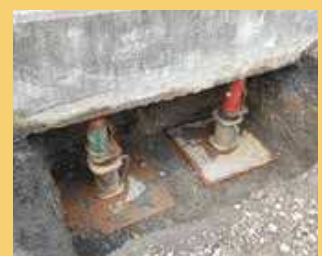
耐圧板使用の施工状況
