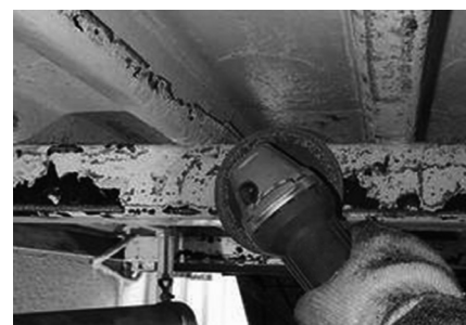
錆補修の現場からケレン作業はなくなります
